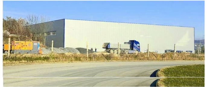
▲ Die Bauarbeiten für das neue Lager der Firma Gourmet haben bereits begonnen.
